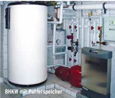
Im laufenden Feldtest liefern die BHKW Strom und Wärme sowie Warmwasser. Zur Steigerung der Energieeffizienz ist ein 600-Liter-Pufferspeicher für Heiz- und Brauchwarmwasser integriert.
