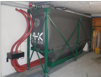
Abb. 14: Trogsilo mit mehreren Saugentnahmepunkten
