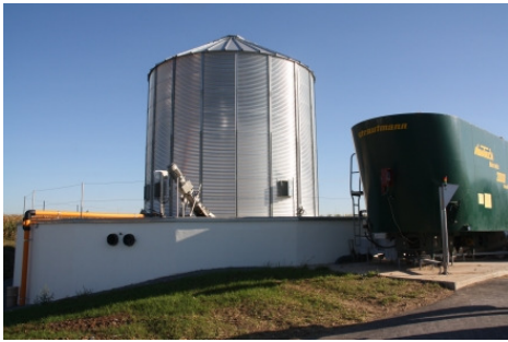
Fermenter, Gasbehälter und Mischer der Biogasanlage
